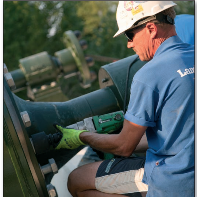
Einbau oberes Lager
